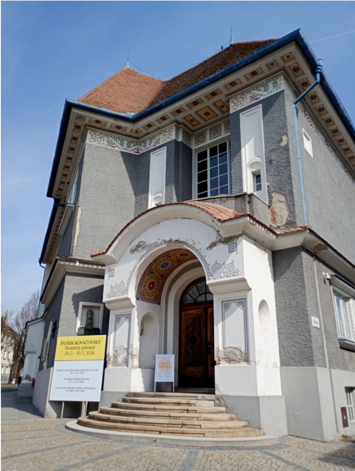
Celkový pohled na budovu
